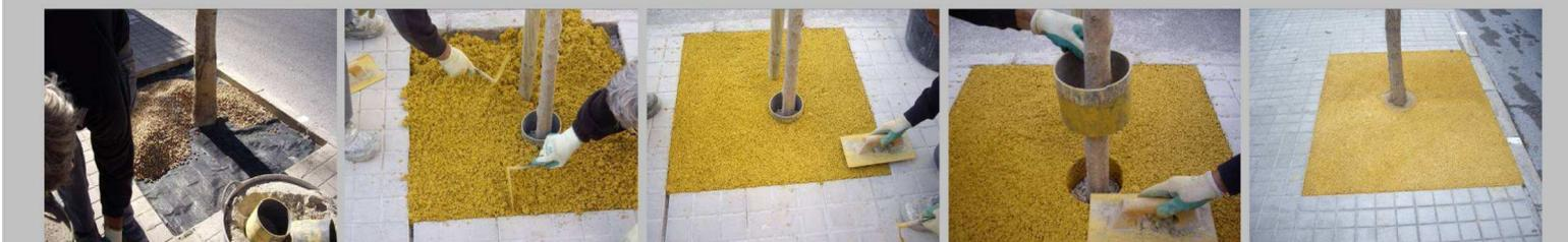
El PAVIMENTO DRENANTE es un hormigón premezclado en seco a base de cemento, áridos calizos de granulometría controlada y aditivos que mejoran sus propiedades de plasticidad y trabajabilidad.
